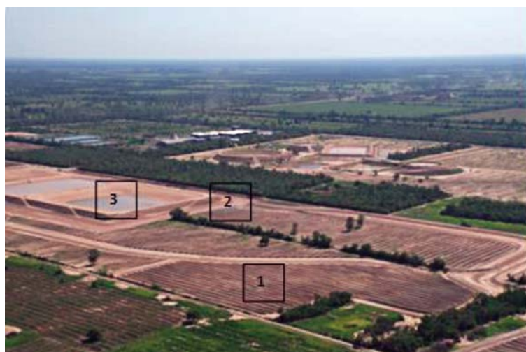
Fotografía 27. Complejo de captación y almacenamiento de agua de la Planta Frigorífica Loma Plata, Áreas de captación (1), tajamar pulmón (2), reservorios tipo tajamar represa (3).
