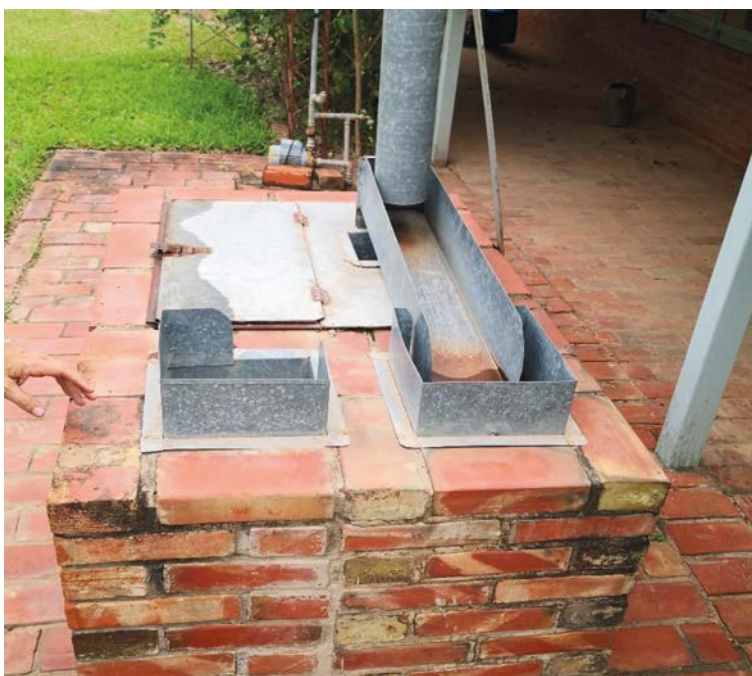
Fotografía 11. Punto de administración de agua de lluvia cosechada de techos domiciliarios.
