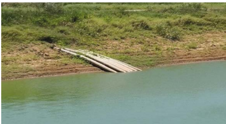
Fotografía 24. Tubos de acceso del agua al tajamar principal para evitar la erosión.
