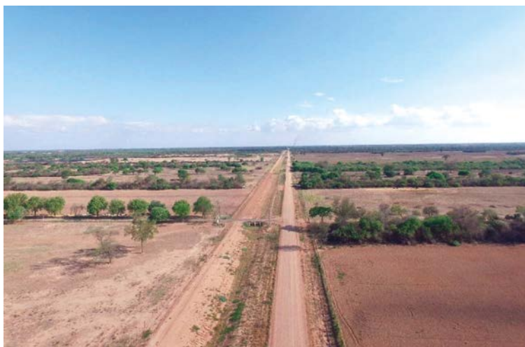
Fotografía 21. Muro y canal de deriva de agua de lluvia al oeste de la ciudad de Loma Plata.
