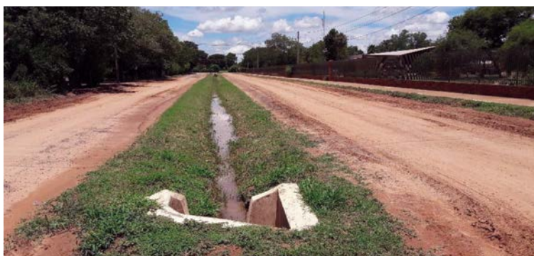
Fotografía 14. Avenida sistematizada para colecta y transporte de agua, Neuland.
