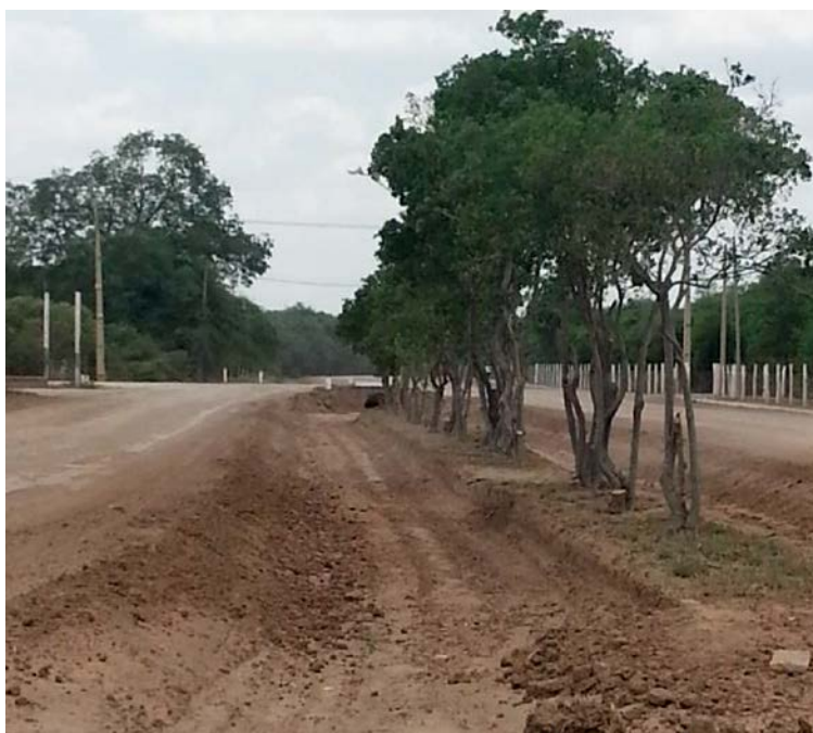
Fotografía 16. Mantenimiento en obras de colecta y transporte de agua, Loma Plata.
