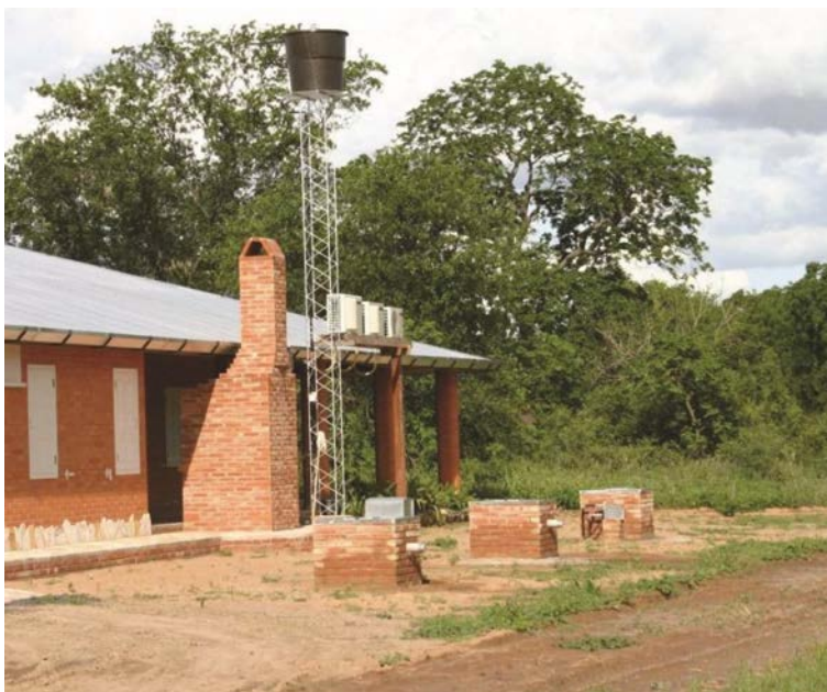
Fotografía 10. Conjunto de aljibes para administración de agua cosechada de diferente calidad.
