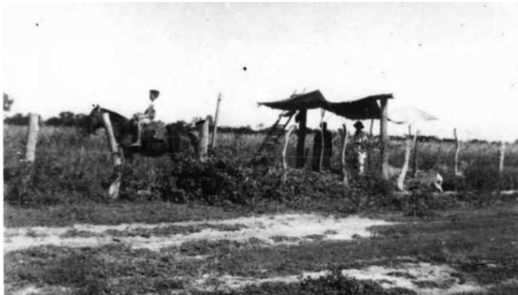
Fotografía 3. Excavación de pozo con ayuda de un caballo para extraer la tierra, Colonia Fernheim, 1950.
