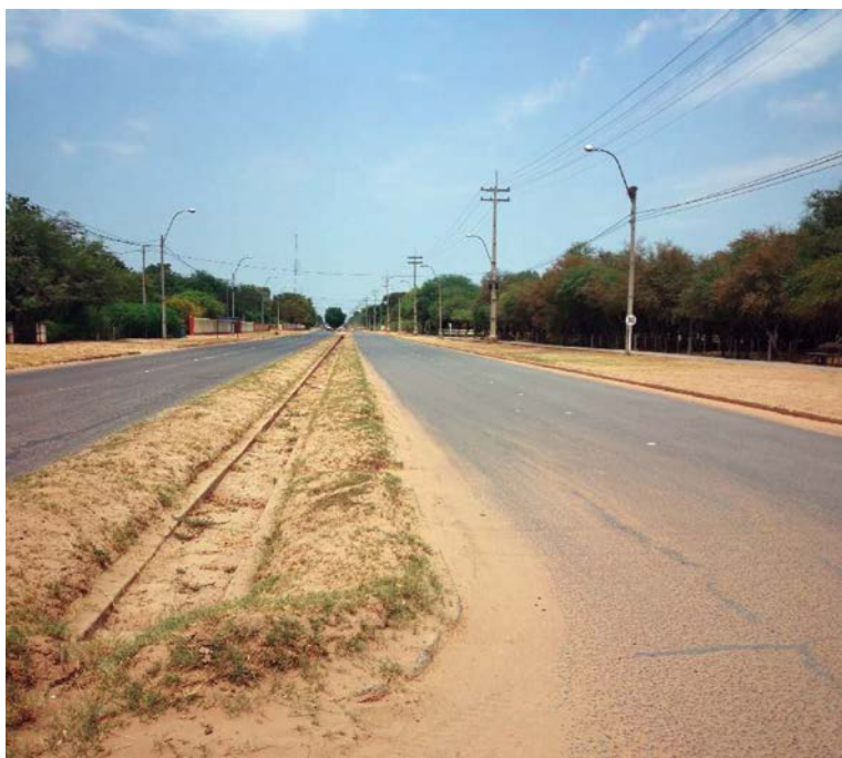
Fotografía 15. Acumulación de sedimentos en canales de conducción de agua, punto importante de mantenimiento del sistema.
