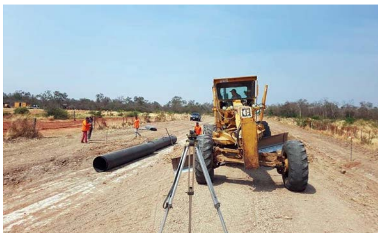
Fotografía 26. Colecta de agua de escorrentía superficial en caminos, zona Tte. Pico, Boquerón (Gentileza de A. Escobar Masi).
