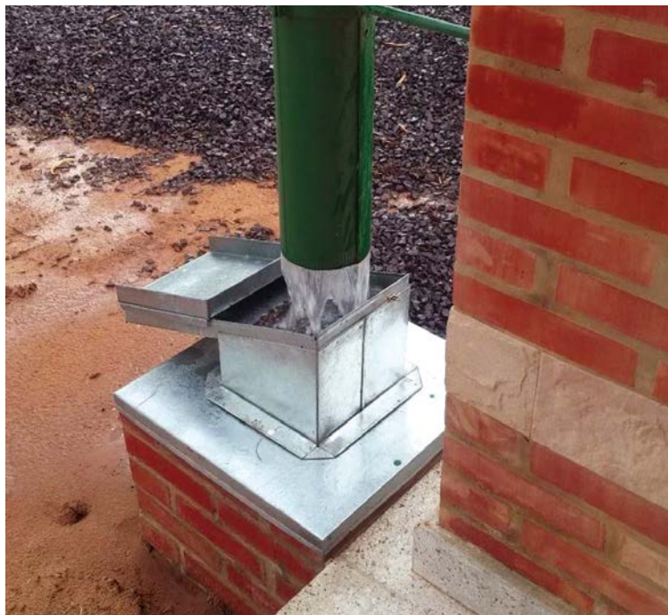
Fotografía 6. Canaletas con filtro contra insectos y otros residuos.
