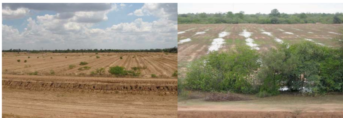
Fotografía 31. Áreas sistematizadas de cosecha de agua con 2,5 años de uso (izquierda, construcción adecuada; derecha, con errores de construcción por la acumulación de agua en los canales).
