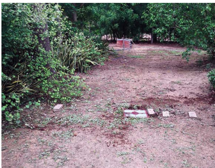
Fotografía 13. Patio domiciliar sistematizado para cosecha de agua. En primer plano, alcantarilla de acopio de agua; en el plano de fondo, aljibe para agua de patio.
