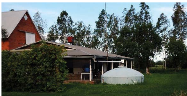
Fotografía 12. Sistema domiciliario de cosecha de agua con aljibe prefabricado de fibra de vidrio.
