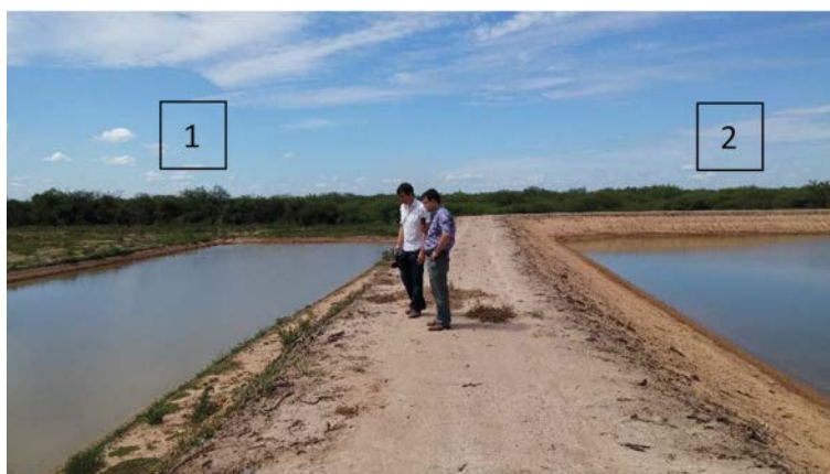
Fotografía 29. Tajamar pulmón (1) y reservorio tipo tajamar represa (2), Tte. 1º Manuel Irala Fernández, Intervenciones físicas demostrativas contra la desertificación y la sequía, IICA.
