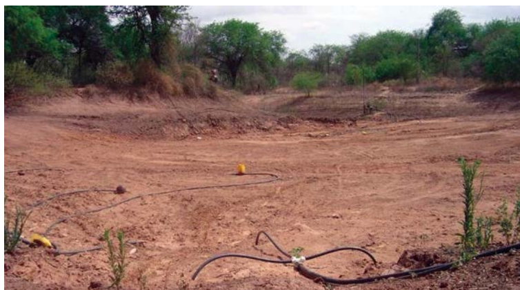
Fotografía 19. Pozos tipo bombilla con perforaciones múltiples en un tajamar de infiltración de agua.
