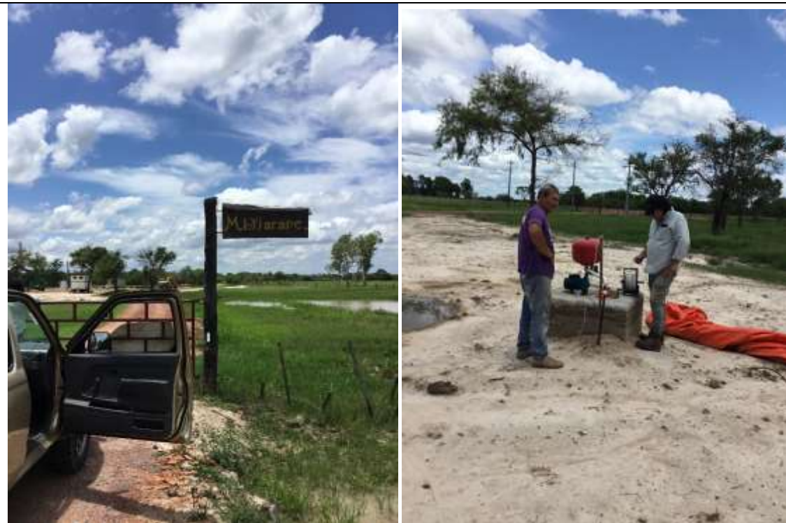
Pozo en la zona del bajo Chaco- Falcon - Agua dulce del acuífero aluvial, cercano a un brazo del río Pilcomayo . NE de 5.76 m
